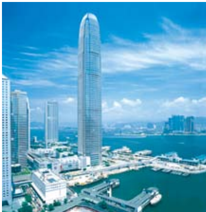
香港-国际金融中心 举世知名, 综合性新建筑
